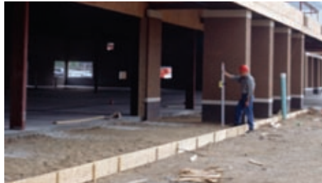
Schalungen und Fundamente
